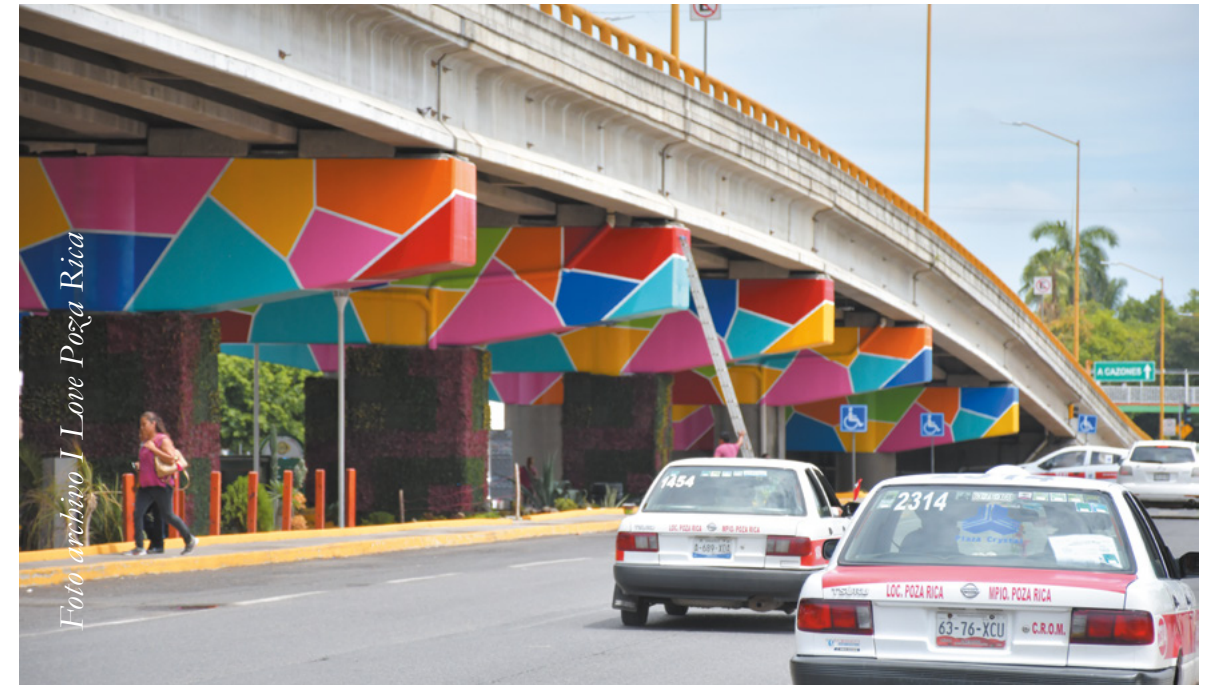
Tráfico en los bajos del distribuidor vial
