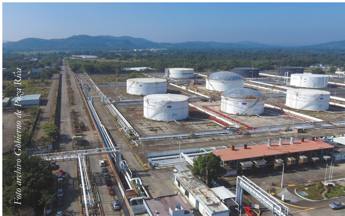
Lo que fuera la Petroquímica Escolín desde las alturas
