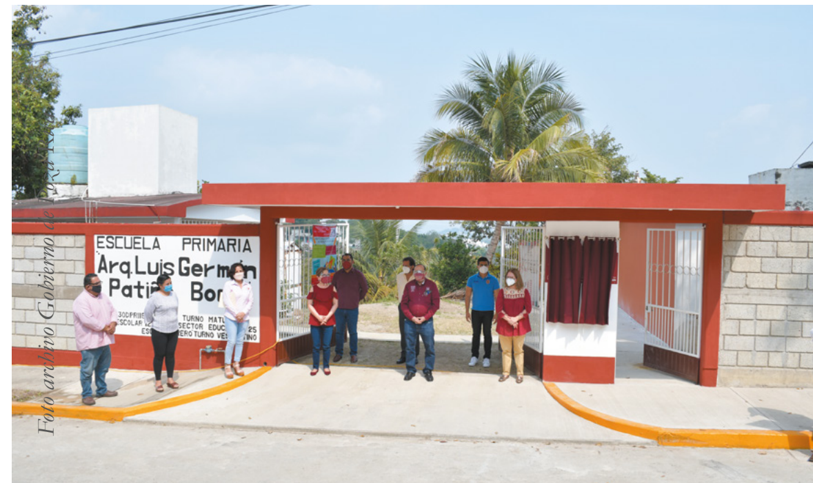
Entrega de obra en escuela
